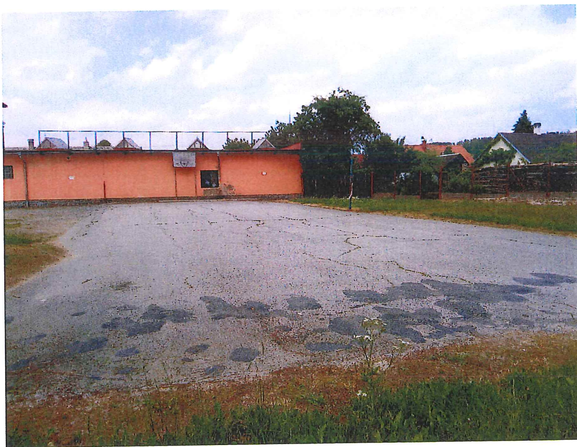
Obrázek 5 tenisový kurt s asfaltovým povrchem
